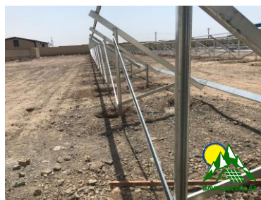
ریگلاژ نهایی جهت بتن ریزی
