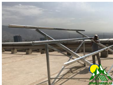
نصب پرلینها و بادبندها
